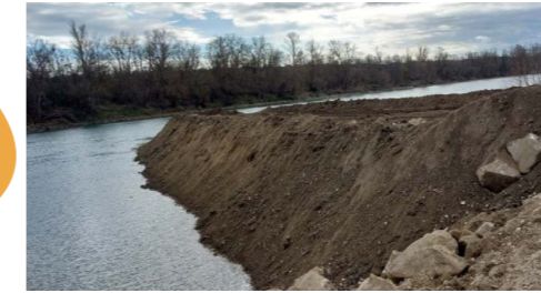
Zone de réinjection sédimentaire
