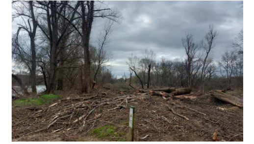
Déboisement emprise chantier
