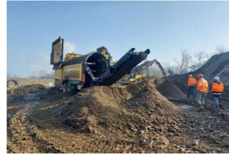
Criblage de la renouée
