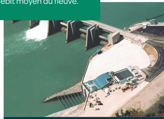
Mise en service de la petite centrale hydroélectrique 2000
