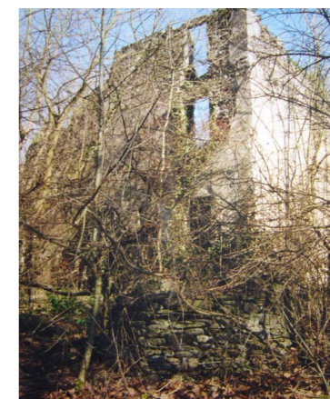
Restauration de la ferme au Loup 2003
